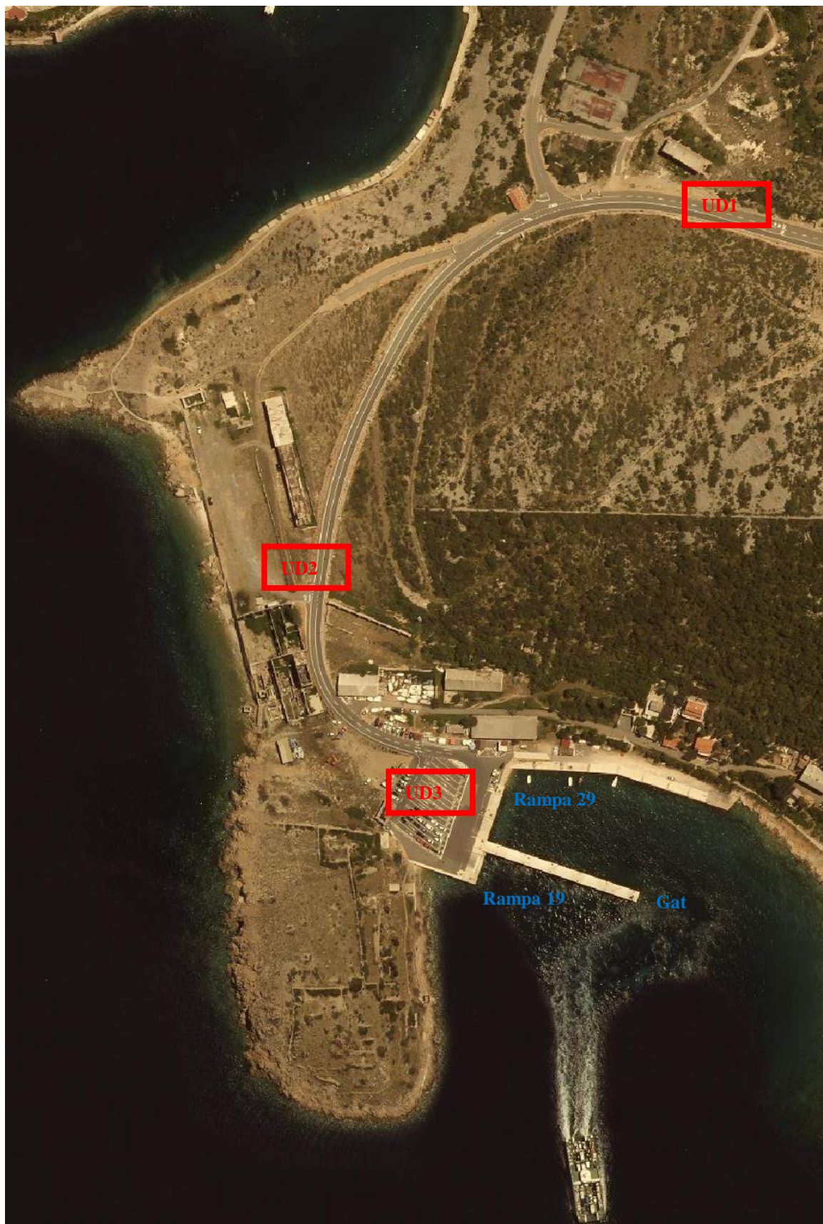
Slika 19. Postojeće stanje trajektnog pristaništa na orto-fotu
